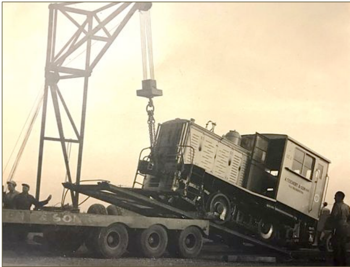
Nº 2038, rotulado para la constructora que lo adquirió después de la Segunda Guerra Mundial, siendo cargado en un camión de carretera.
